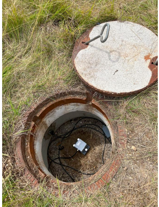
Seismometer an der Erdoberfläche
