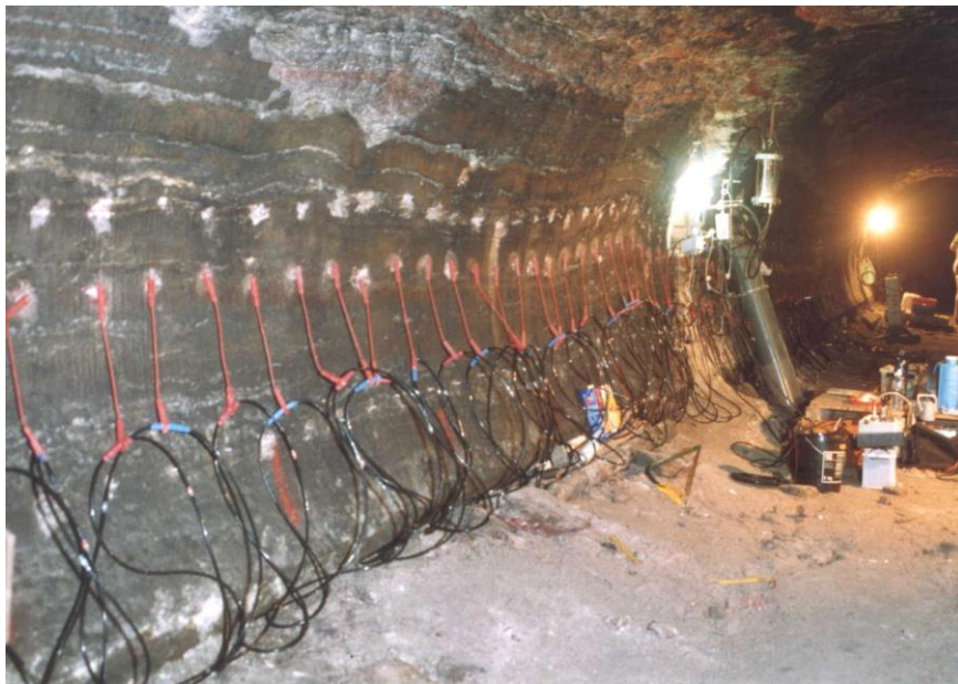
Abbildung 3: Messapparatur am Nordstoß und Vorrichtung zur Laugeninjektion
