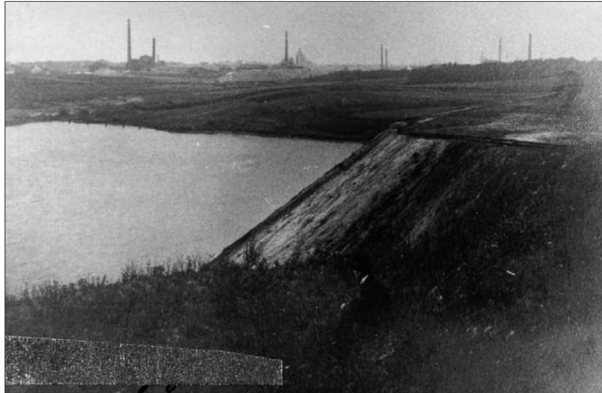
Abb. 11: Der Tagesbruch „Am Strandbad“ um 1920. Zu sehen sind Feldbahnschienen zum Transport von Bauschutt und Fabrikrückständen, mit denen der Tagesbruch aufgefüllt und zum Strandbad umgestaltet wurde (1929).
