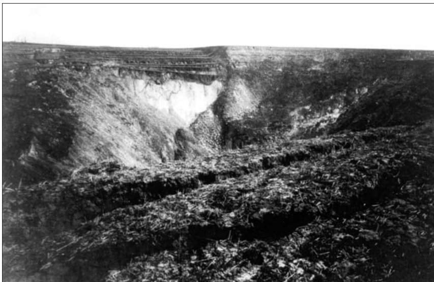
Abb. 7: Ausdehnung und Orientierung des Tagesbruchs „Am Strandbad“ (gefallen am 26.6.1899) über den Grubenbauen der Kali-grube Leopoldshall I/II. Dargestellt ist die Ausdehnung des Tagesbruches im Oktober 1899 über der 2. und 3. Etage.
