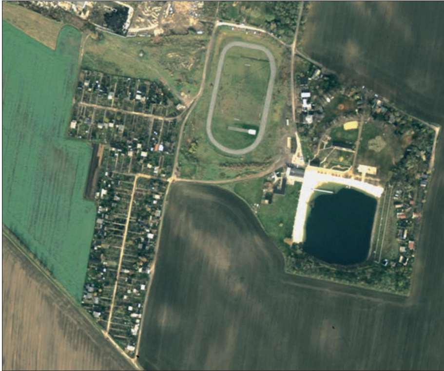
Abb. 17: Luftbild der Bergschadenssituation über dem Grubenfeld Leopoldshall I/III von April 1999. Der ehemalige Schwefelteich ist vollständig aufgefüllt.
