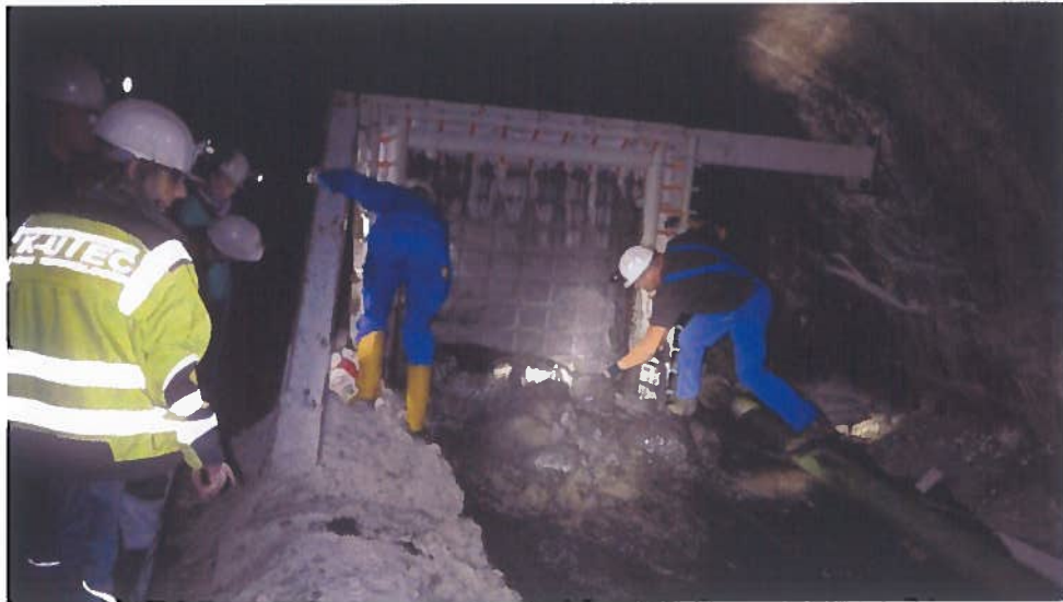
Abbildung KD 24: Demontage Gurtbandnetz Filtermaterial
