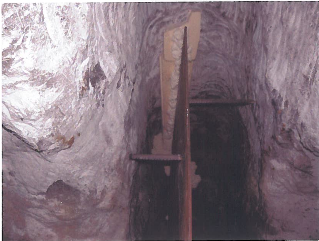
Abbildung KD 3: am Stoß eingeschäumtes Seitenblech als Übergang Bauwerk/Gebirge
