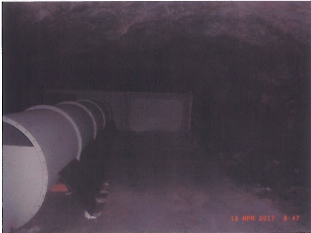
Abbildung KD 14: Kompletter Versuchsstand vor der Bepflügelung (Einspülseite)
