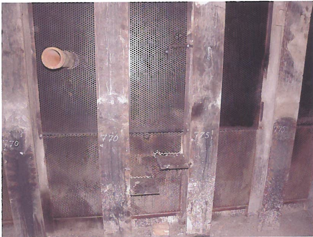
Abbildung KD 5: Stahlbau Dammbauwerk mit aufgesetzten Lochblechen
