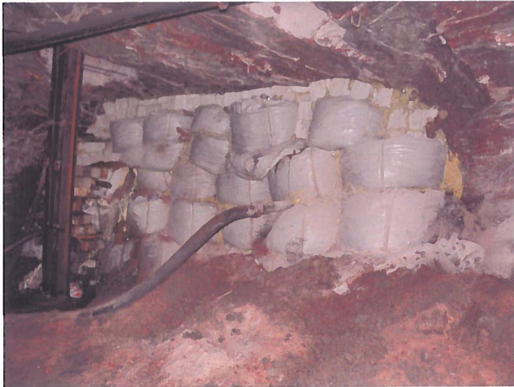
Abbildung KD 6: Dammbauwerk aus Big Bags aufgetürmt mit Drainageschlauch
