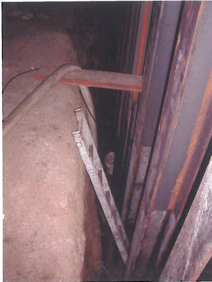
Abbildung KD 1: Stahlträger des Dammbauwerkes in der eingefräst Nut auf der Sohle der zu füllenden Abbaukammer
