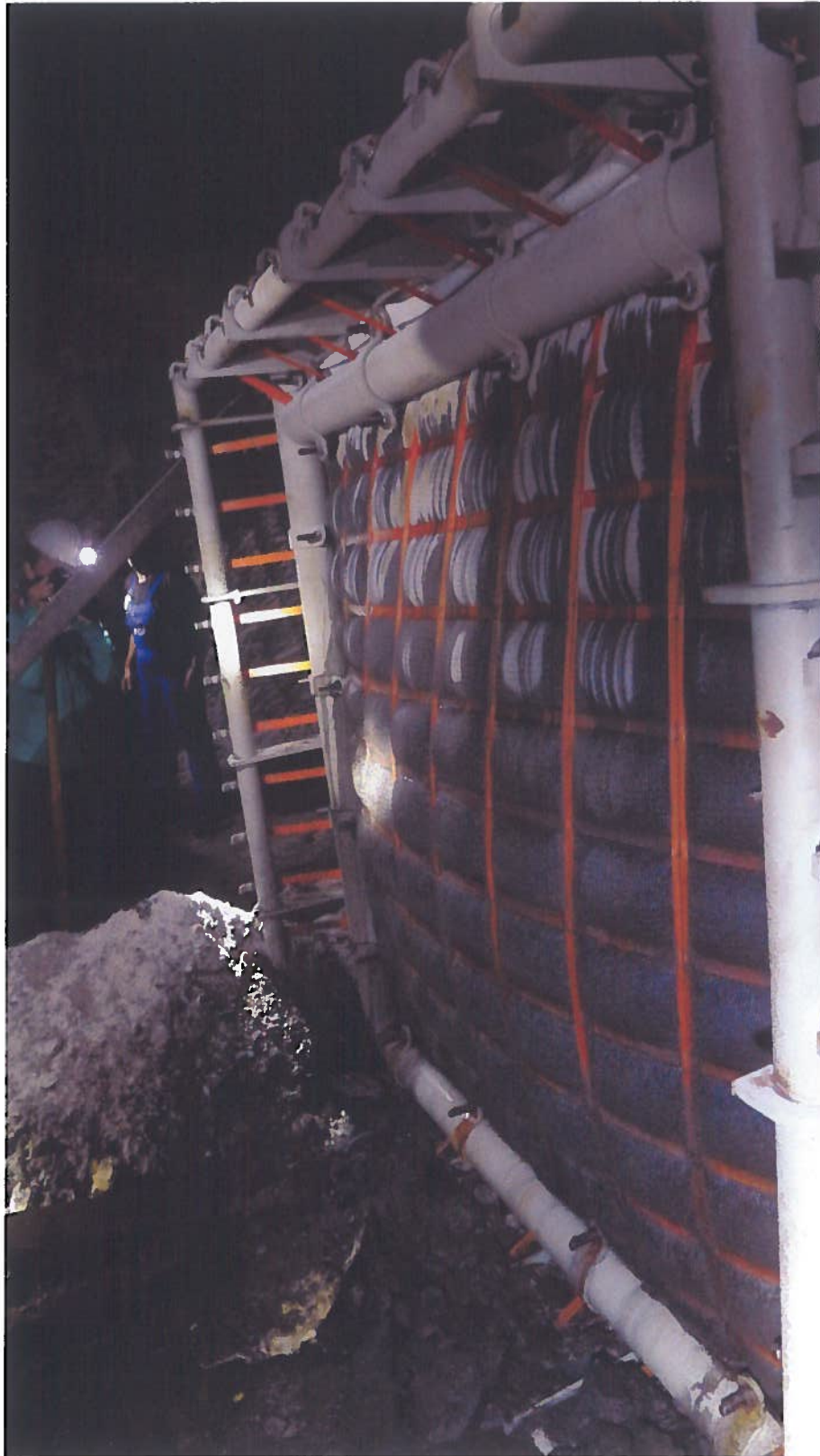
Abbildung KD 27: Bemusterung Stahlbau
