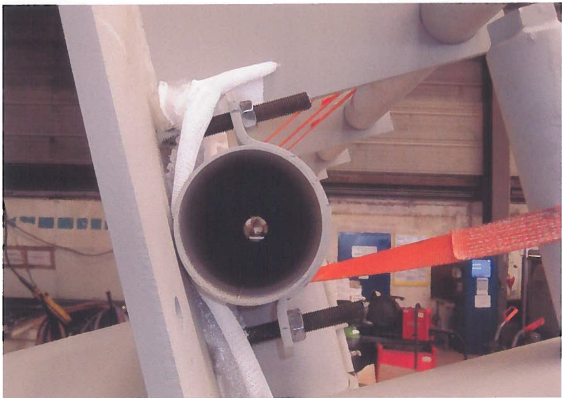
Abbildung STFI 6: Einbau der Abstandsgewirke in die Aufnahmevorrichtung
