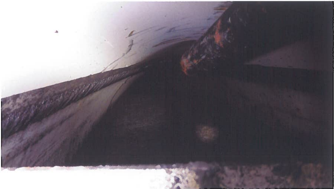
Abbildung KD 22: Füllstand vor Öffnen des Filtertextils
