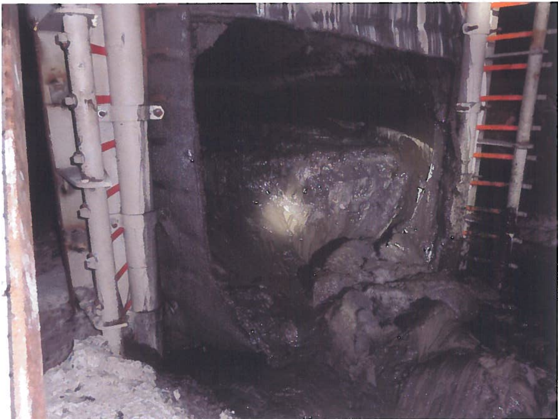
Abbildung STFI 16: Suspension / Versatzmasse – größtenteils ausdrainiert
