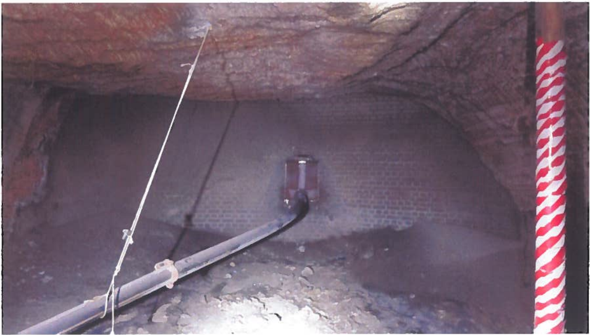
Abbildung KD 29: Gemauerte Wand mit Drainagefenstern
