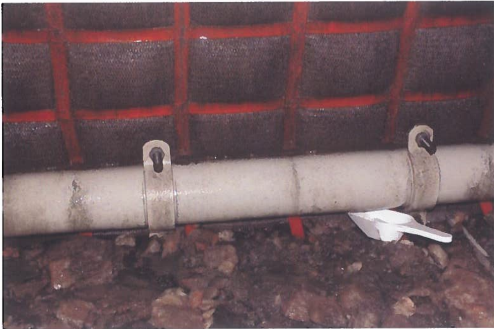
Abbildung K-UTEC 17: Detailansicht ausdrainierende klare Lauge
